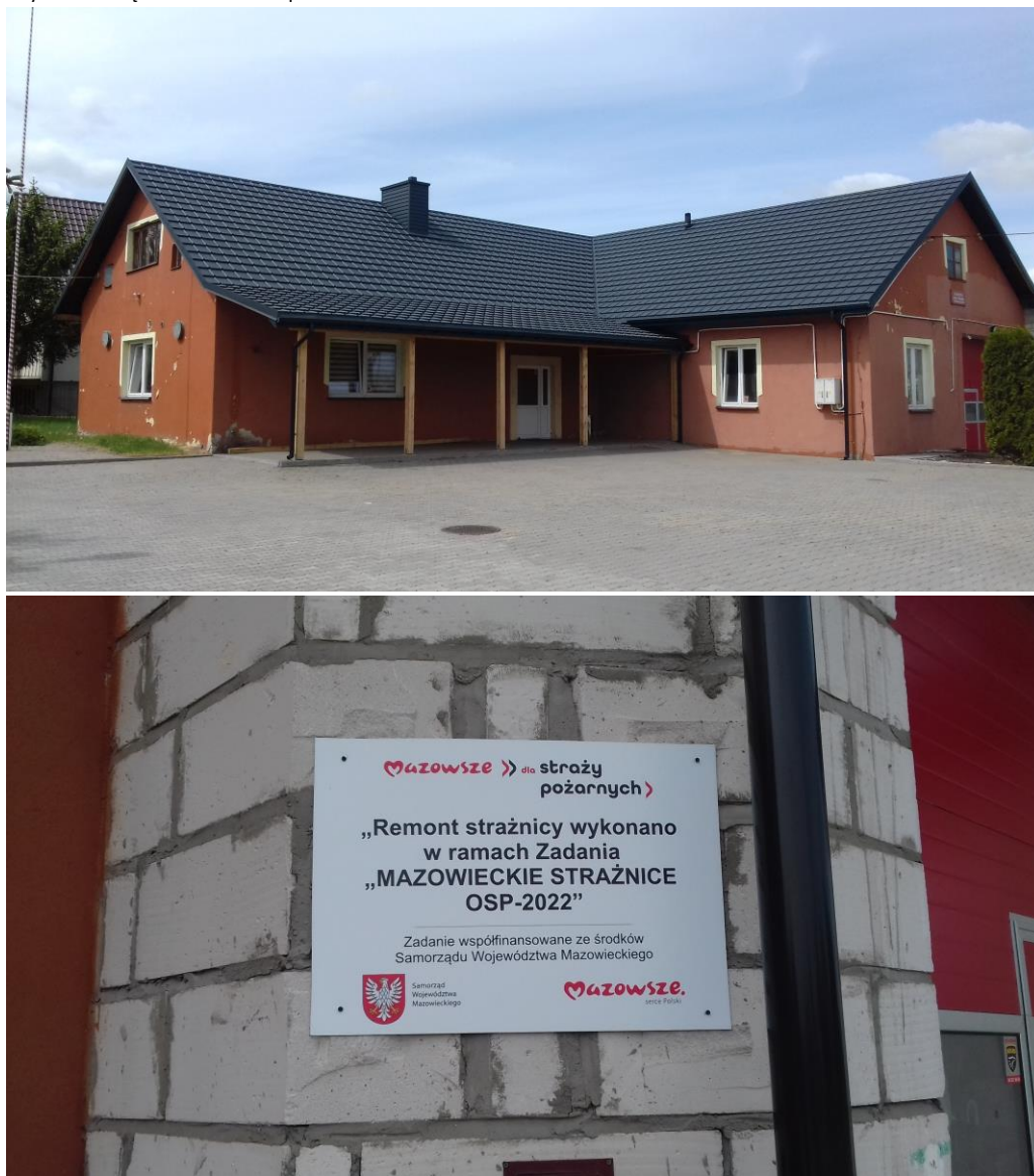
Fot.19 Budynek OSP Bądkowo Kościelne po remoncie dachu
