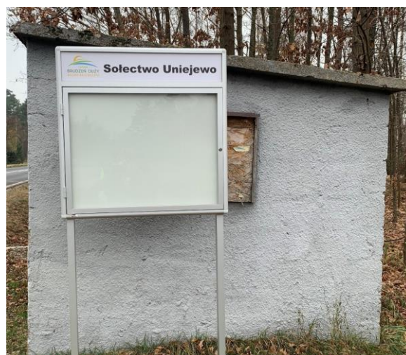
Fot. 29 Lampy solarne oraz gabloty informacyjne w m. Uniejewo
