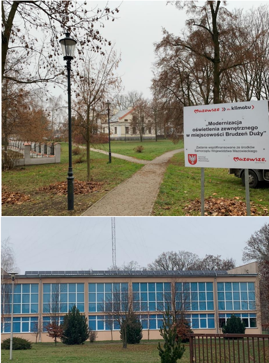
Fot.17 Lamy oraz panele fotowoltaiczne w Parku w Brudzeniu Dużym
