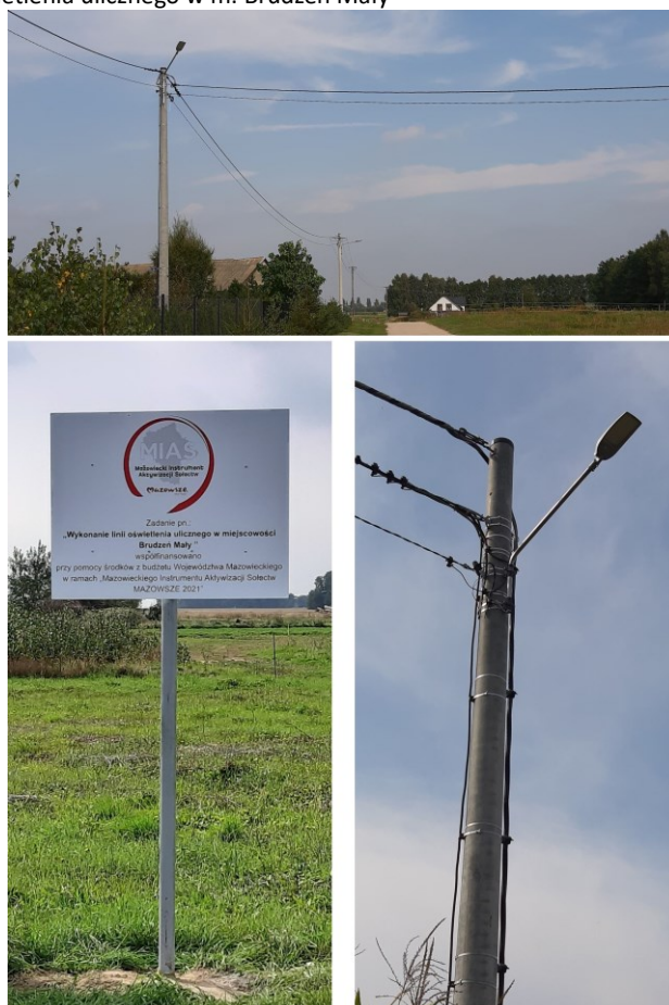
Fot. 12 Wykonanie linii oświetlenia ulicznego w m. Brudzeń Mały
