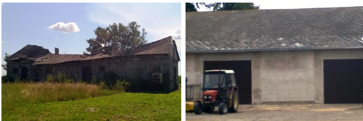
Rysunek 1. Wyroby azbestowo – cementowe: po lewej płyty faliste, po prawej płyty płaskie
