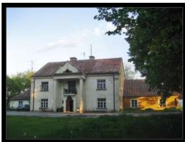
Rys 61 Dworek z 1850 r- wielokrotnie przebudowywany – Sikórz, źródło : galeria.plock24.pl
