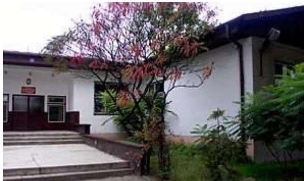
Rys 44 Budynek zlikwidowanej Szkoły Podstawowej im. Macieja Rataja w Głównie. źródło : galeria.plock24.pl
