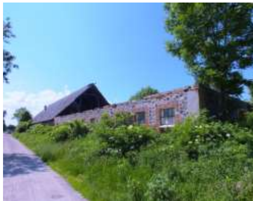
Rys 43 Budynek gospodarczy w Głównie- obecnie zespół zabudowy mieszkalnej, komunalnej zdjęcie – Marcin Skowroński - źródło: www. polskiezabytki.pl
