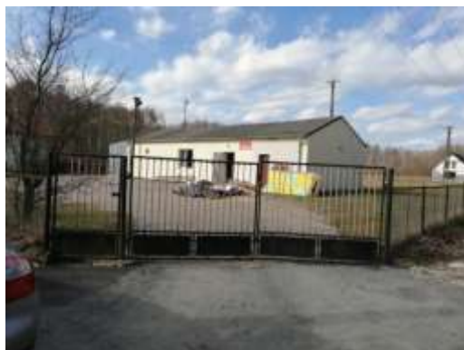
Rys 53 Turza Mała – budynek OSP, źródło : zdjęcie własne
