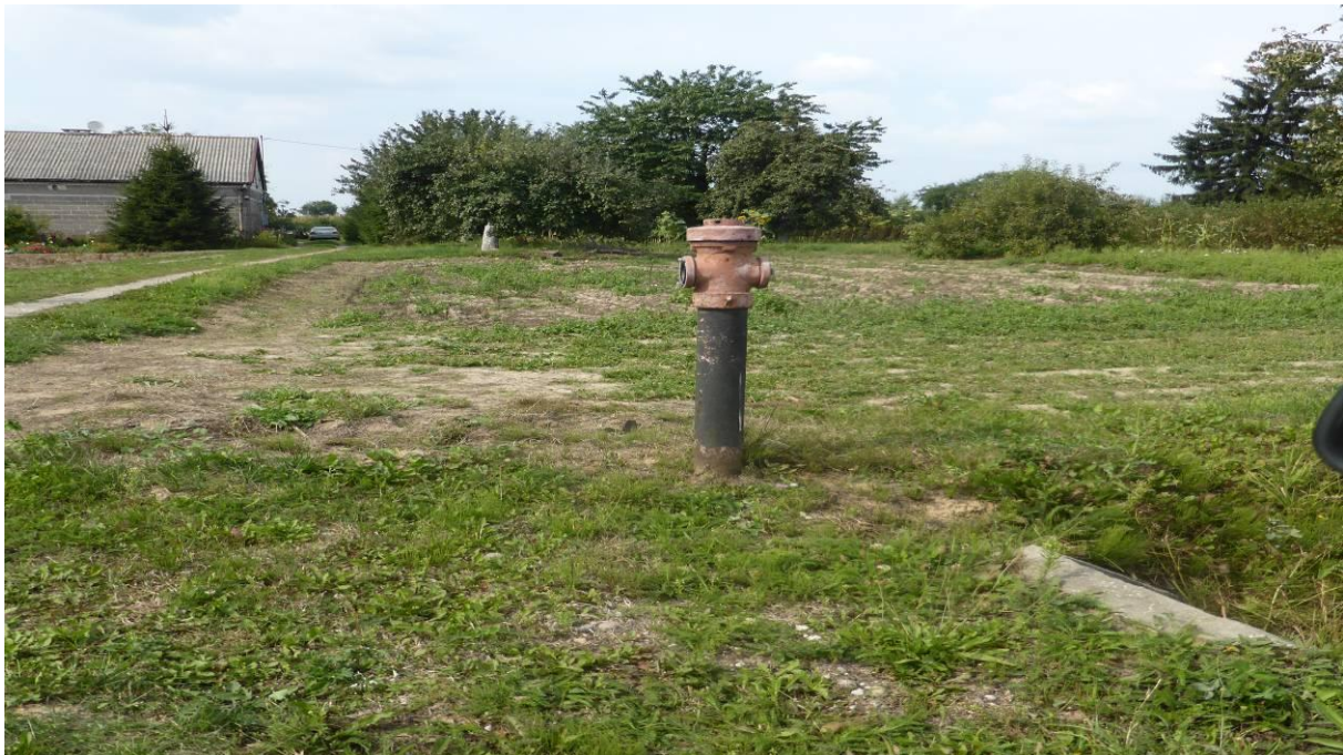
Fot. nr 45. Widok hydrantu ppoż. w Sikorzu
