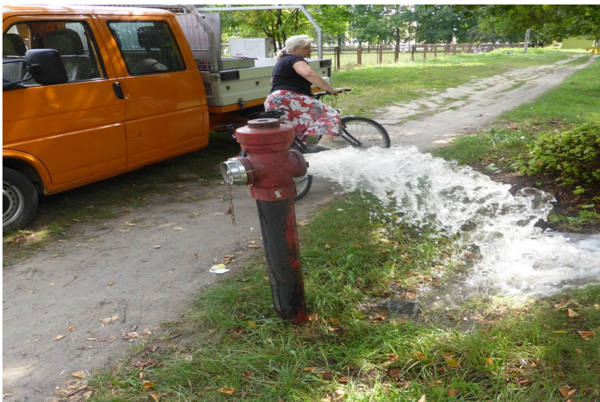
Fot. nr 42. W dniu 30.08.2013r. około godz. 12 ekipa p. Reznarskiego płukała wodociąg przez hydrant ppoż. w Sikorzu, w pobliżu rozwidlenia dróg w kierunku Mochowa i Brudzenia Dużego
