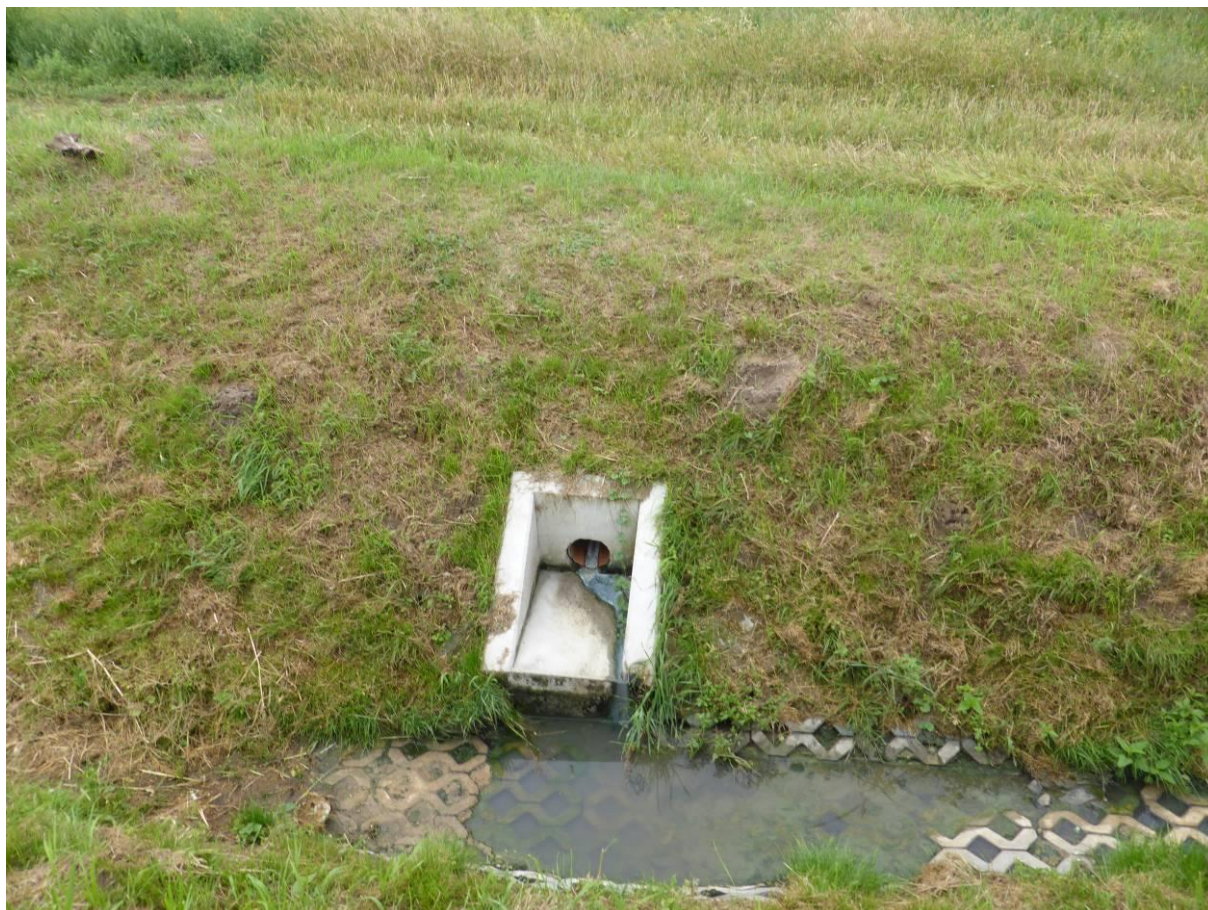
Fot. nr 12. Wylot ścieków oczyszczonych z oczyszczalni ścieków w Siecieniu do rowu melioracyjnego
