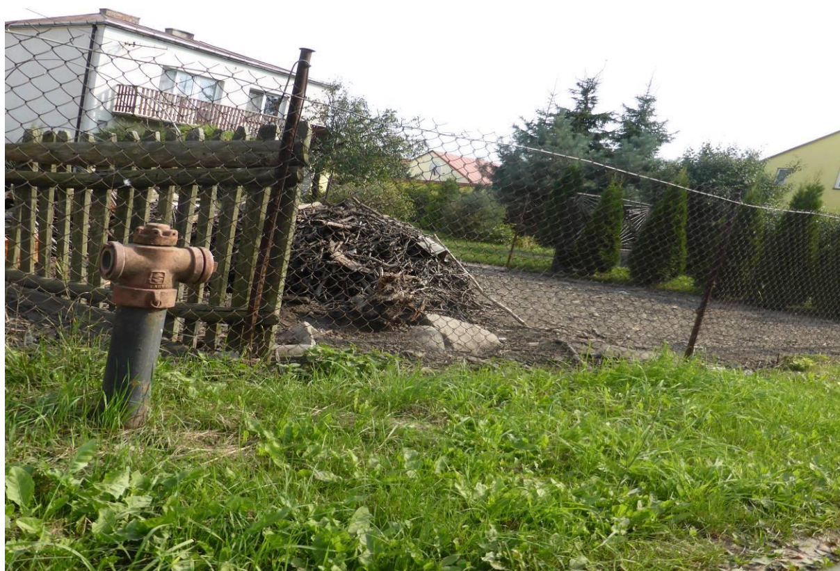
Fot. nr 49. Widok hydrantu ppoż. w Siecieniu
