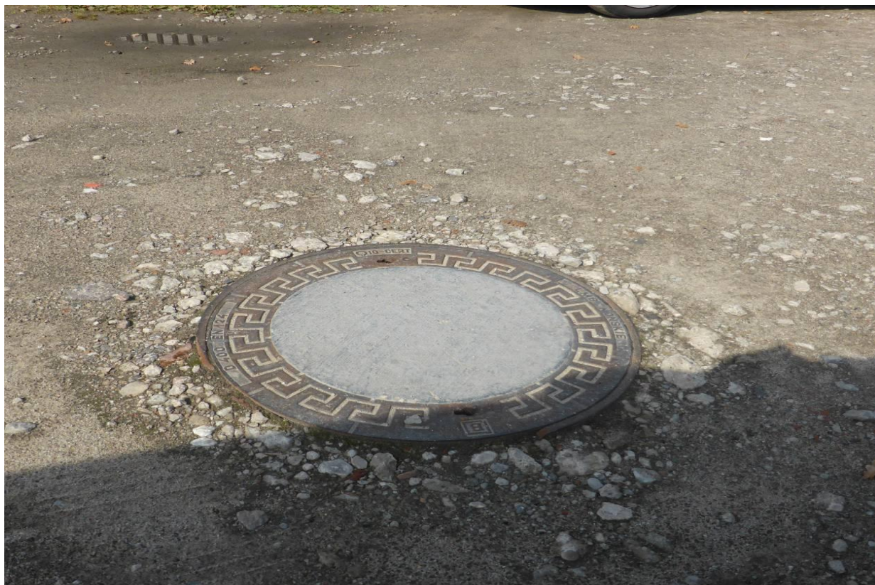
Fot. nr 83. Studnia kanalizacyjna w drodze gruntowej w Brudzeniu Dużym
