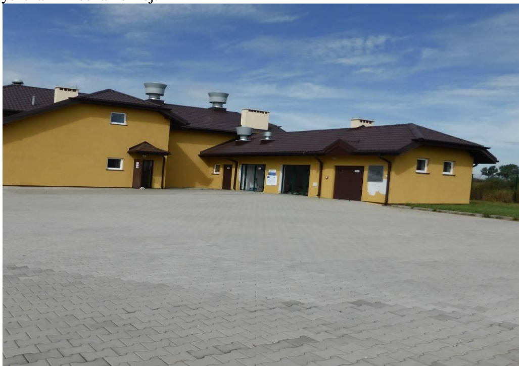
Fot. nr 6. Widok budynku oczyszczalni ścieków w Siecieniu
