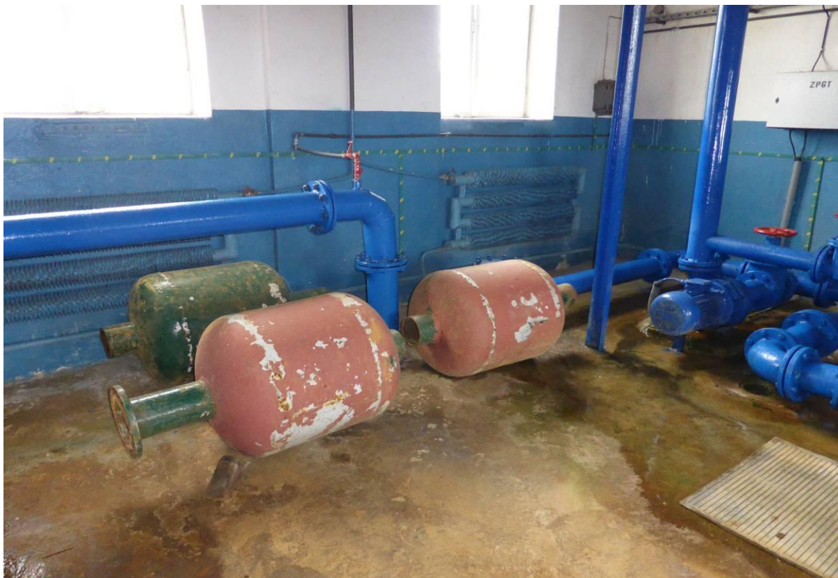
Fot. nr 19. Zdemontowane stare aeratory stacji uzdatniania wody w Brudzeniu Dużym
