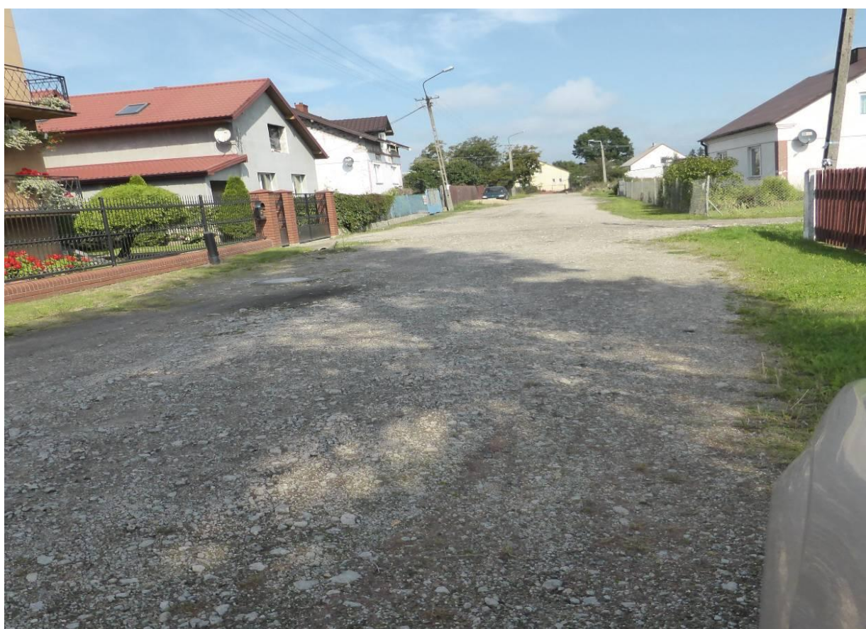
Fot. nr 86. Studnia kanalizacyjna w drodze gruntowej w Brudzeniu Dużym
