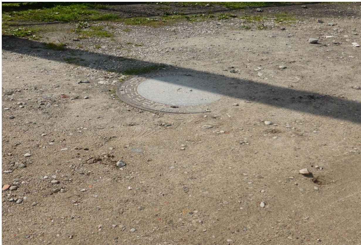
Fot. nr 87. Studnia kanalizacyjna w drodze gruntowej w Brudzeniu Dużym
