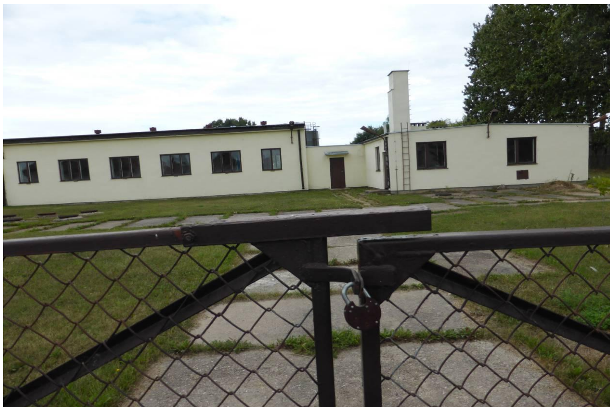
Fot. nr 17. Widok stacji uzdatniania wody w Brudzeniu Dużym
