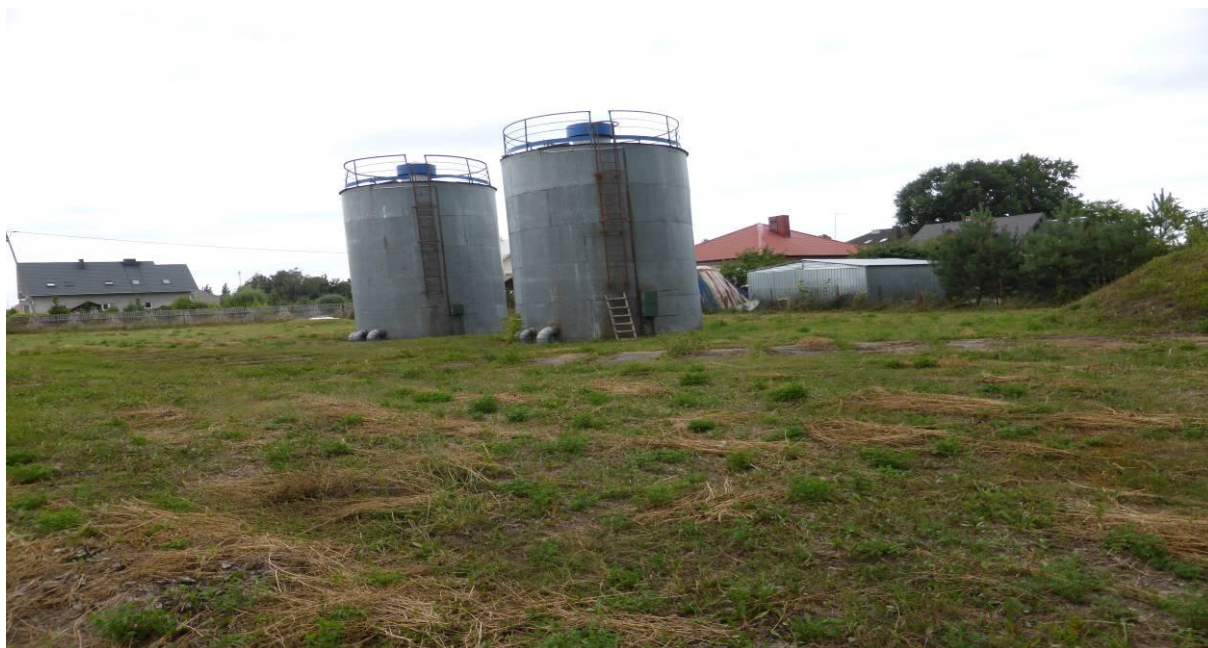
Fot. nr 23. Widok zewnętrznych zbiorników o pojemności 2 \times 80 \text{ m}^3 na stacji uzdatniania wody w Brudzeniu Dużym
