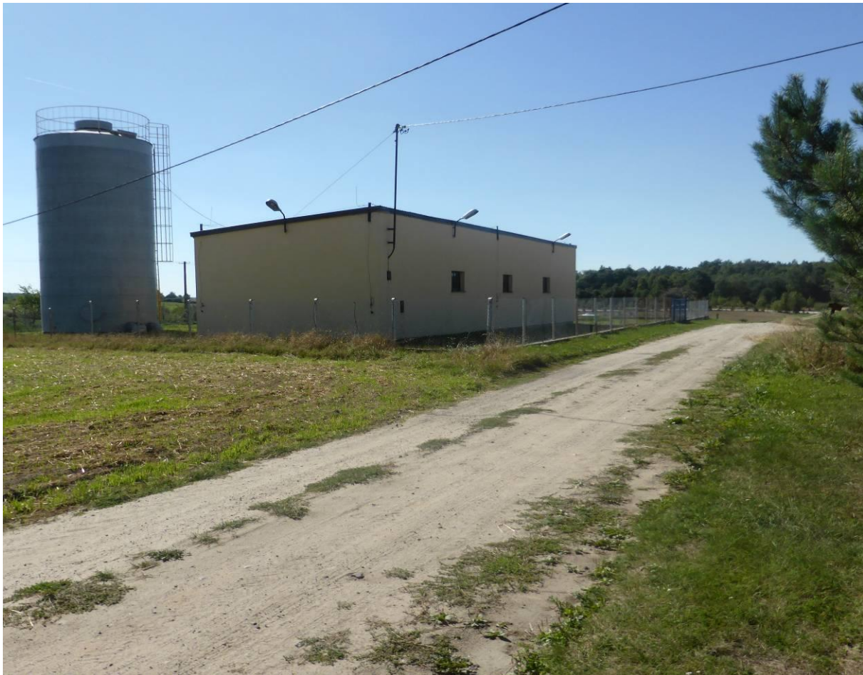
Fot. nr 30. Widok budynku stacji uzdatniania wody w Karwosiekach
