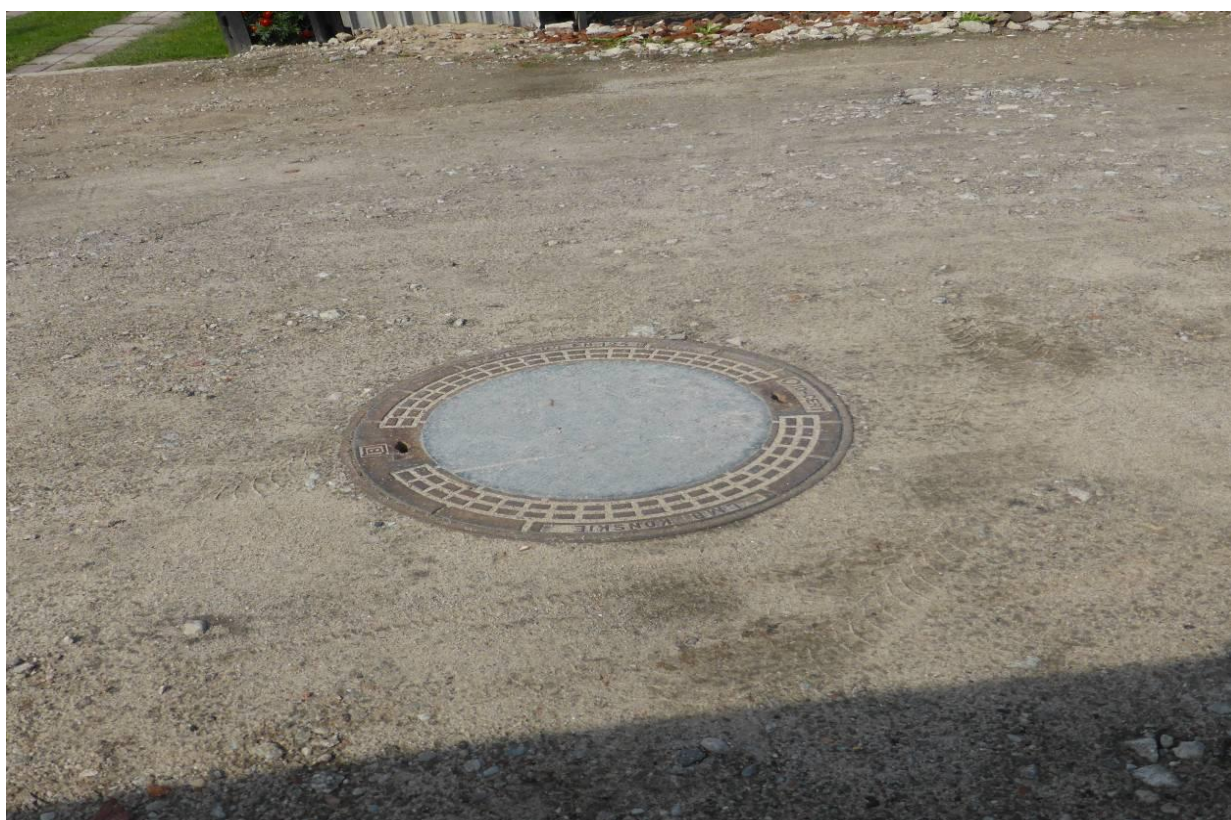
Fot. nr 84. Studnia kanalizacyjna w drodze gruntowej w Brudzeniu Dużym
