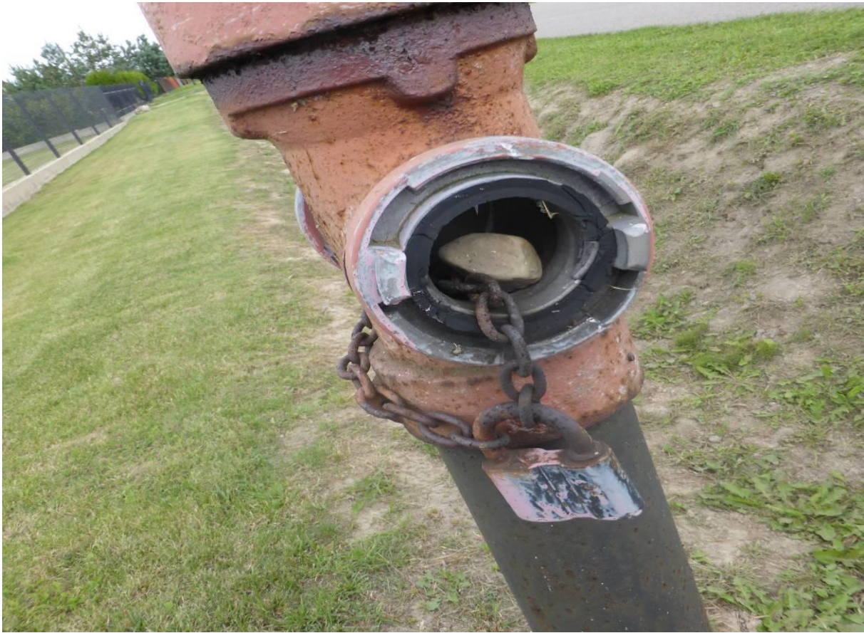
Fot. nr 43. Widok hydrantu ppoż. w Sikorzu - uwagę zwraca łańcuch uniemożliwiający szybkie jego wykorzystanie
