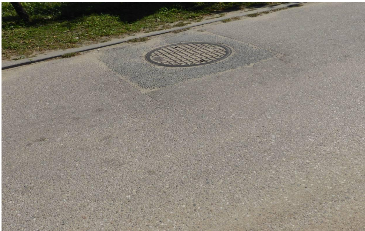
Fot. nr 73. Studnia kanalizacyjna w drodze asfaltowej w Brudzeniu Dużym
