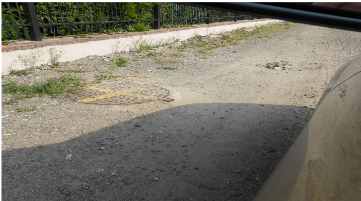
Fot. nr 71. Widok pokryw dwóch studni kanalizacji sanitarnej Siecieniu
