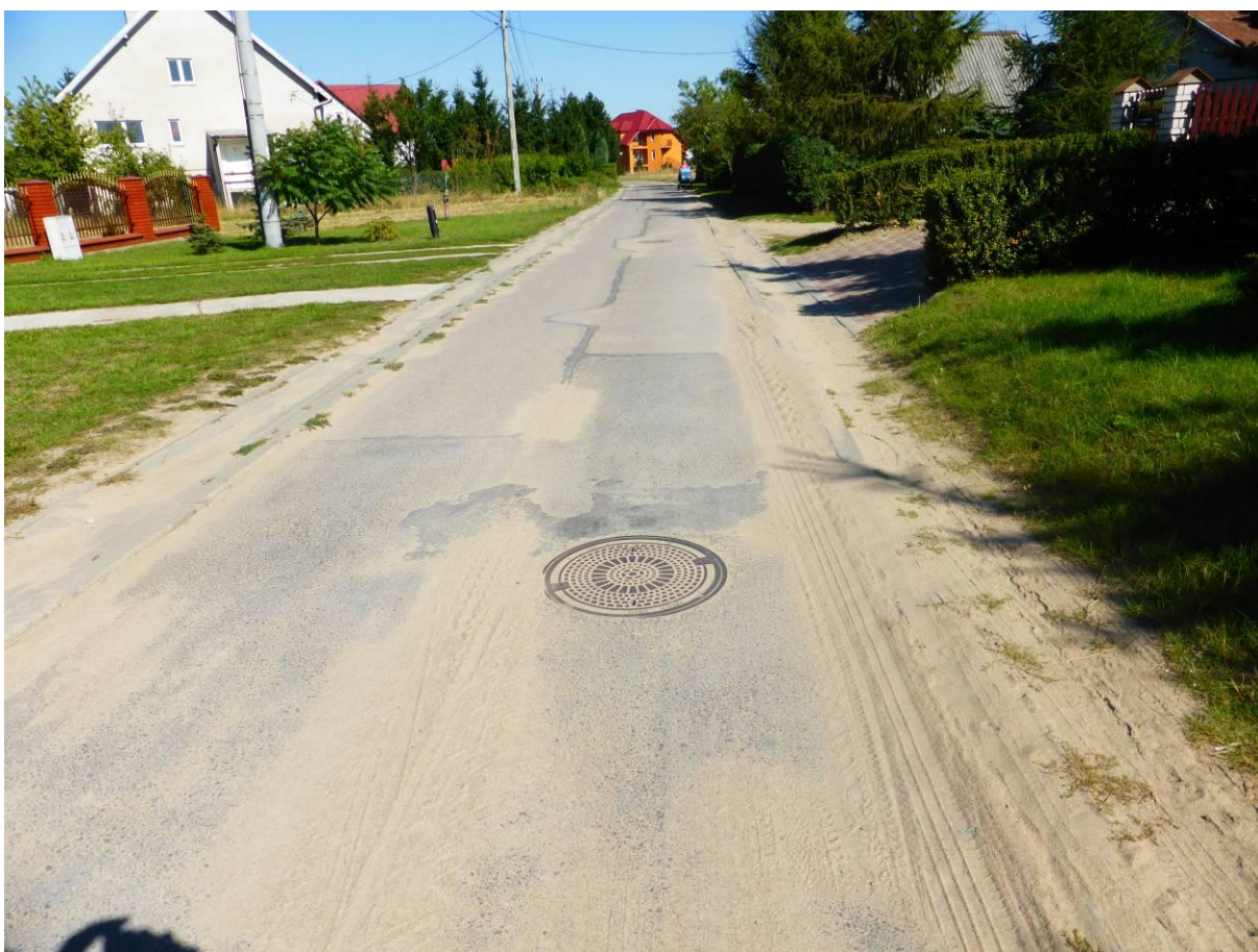
Fot. nr 72. Studnia kanalizacyjna w drodze asfaltowej w Brudzeniu Dużym
