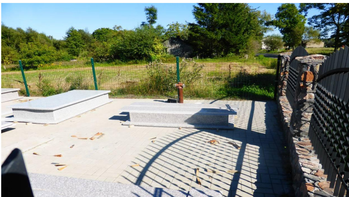
Fot. nr 65 Hydrant w Sobowie na posesji prywatnej
