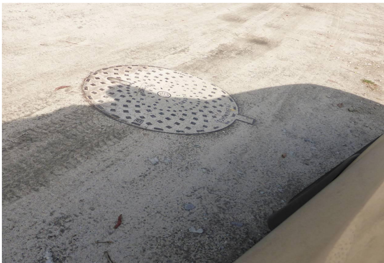
Fot. nr 85. Studnia kanalizacyjna w drodze asfaltowej w Brudzeniu Dużym
