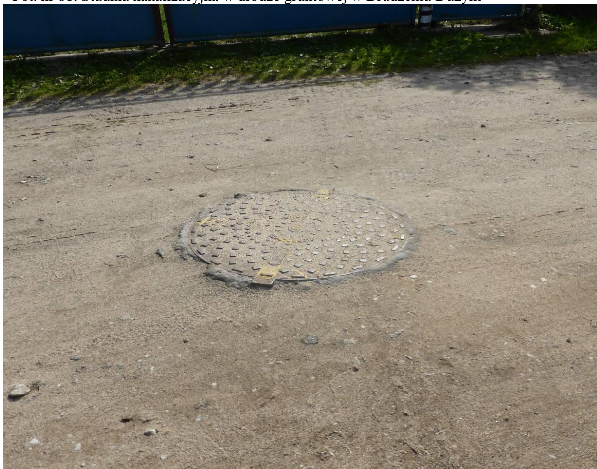
Fot. nr 82. Studnia kanalizacyjna w drodze gruntowej w Brudzeniu Dużym
