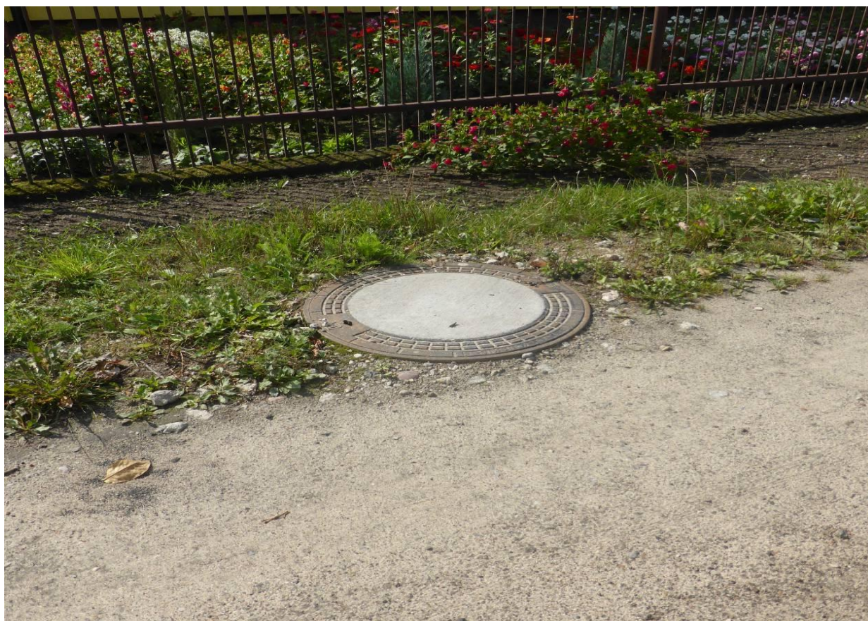
Fot. nr 88. Studnia kanalizacyjna w drodze gruntowej w Siecieniu
