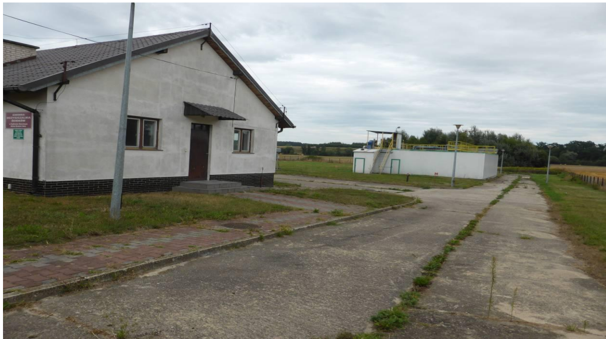
Fot. nr 24. Widok oczyszczalni ścieków w Brudzeniu Dużym
