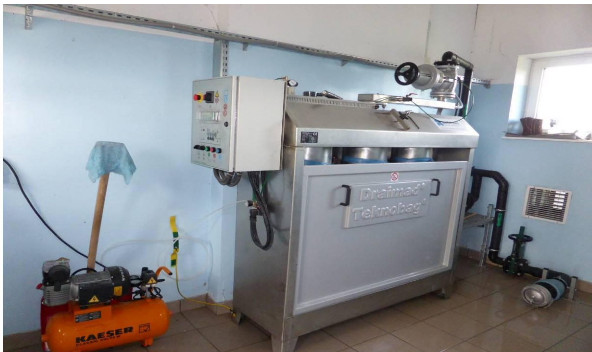
Fot. nr 10 . Urządzenie do odwadniania osadu typ DRAIMAD w oczyszczalni ścieków w Siecieniu
