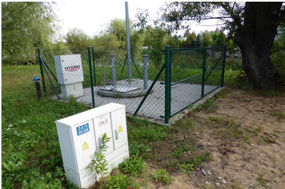
Fot. nr 14. Widok przepompowni nr 2 w pobliżu ujęcia wody w Siecieniu
