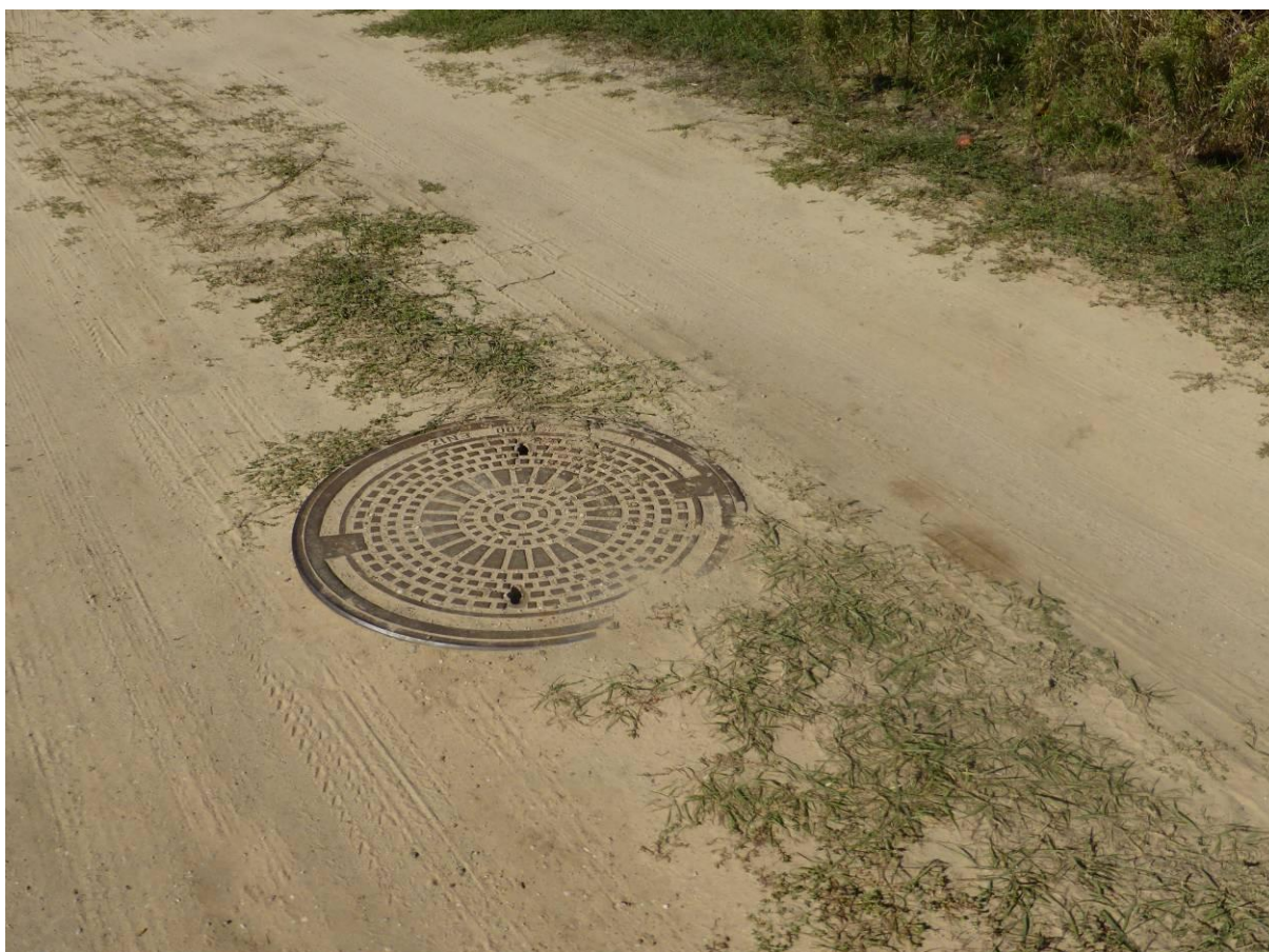
Fot. nr 74. Studnia kanalizacyjna w drodze gruntowej w Brudzeniu Dużym
