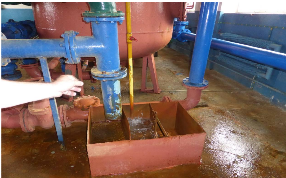
Fot. nr 21. Dodatkowe napowietrzanie grubo pęcherzykowe wody na stacji uzdatniania wody w Brudzeniu Dużym
