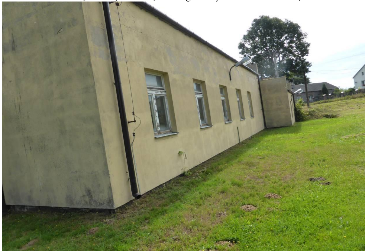
Fot. nr 1 Widok budynku stacji uzdatniania wody w Siecieniu
