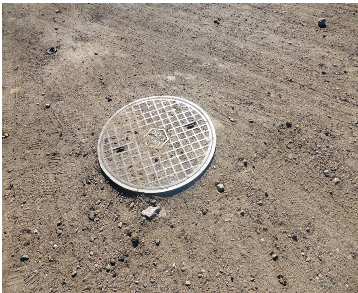
Fot. nr 80. Studnia kanalizacyjna w drodze gruntowej w Brudzeniu Dużym
