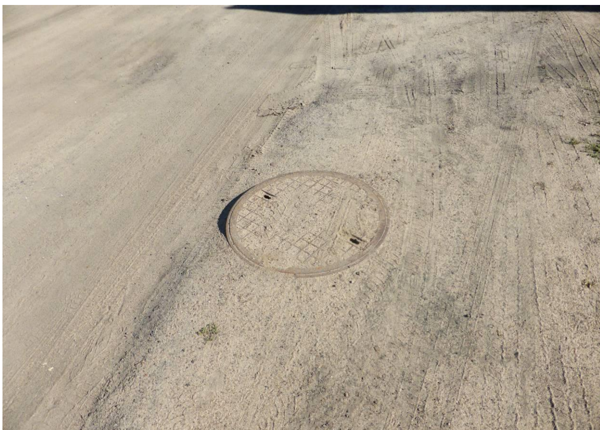
Fot. nr 76. Studnia kanalizacyjna w drodze gruntowej w Brudzeniu Dużym
