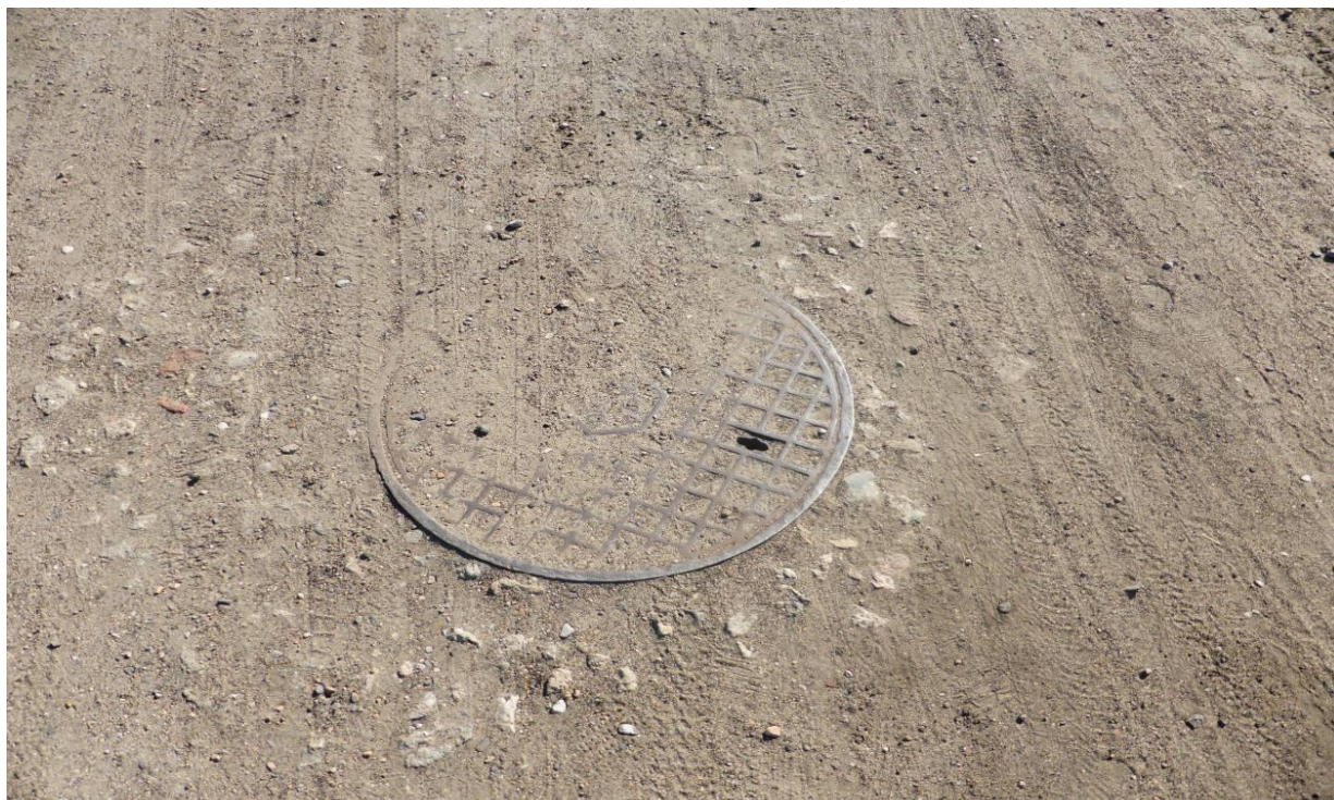
Fot. nr 81. Studnia kanalizacyjna w drodze gruntowej w Brudzeniu Dużym
