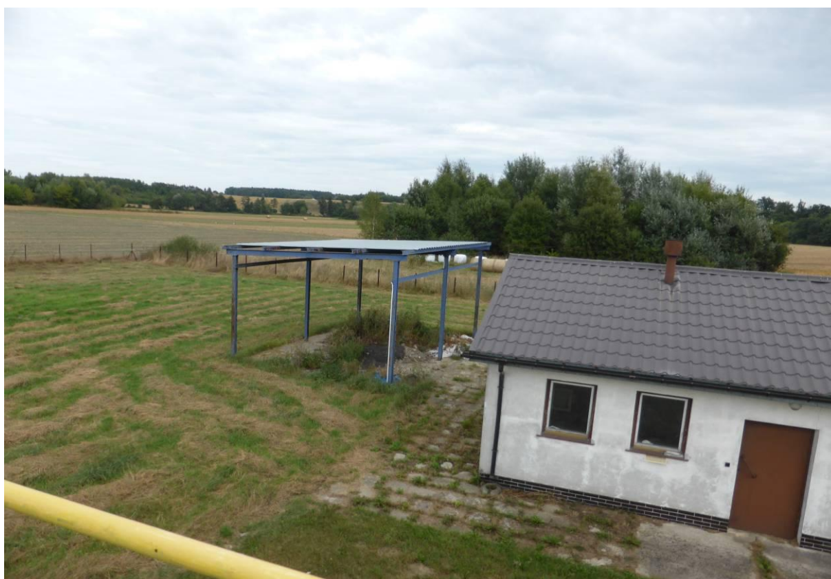
Fot. nr 29. Wiata na „skratki” i osady w oczyszczalni ścieków w Brudzeniu Dużym
