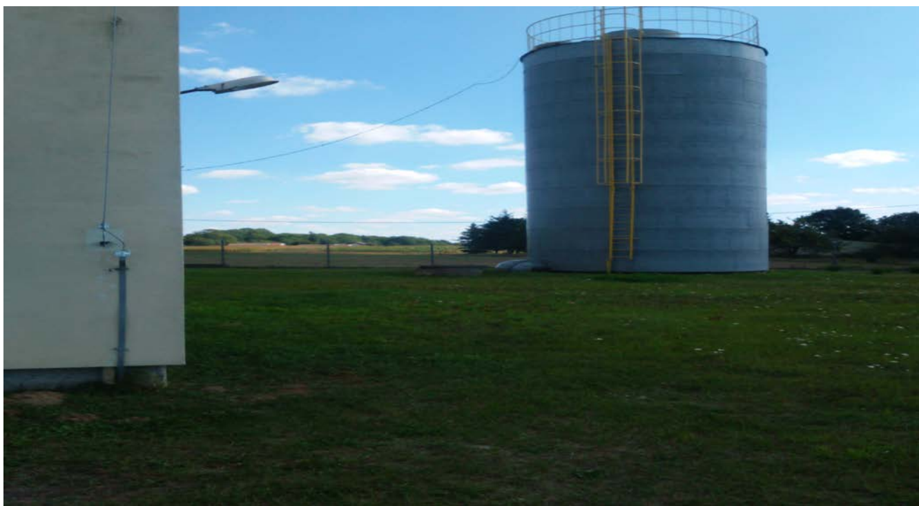
Fot. nr 14. Widok budynku stacji uzdatniania wody w Karwosiekach Cholewiczach
