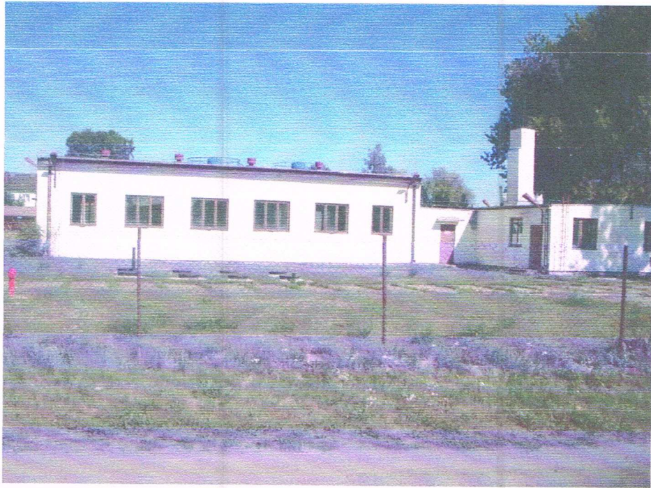
Fot. 1. Na terenie Stacji Uzdatniania Wody w Brudzeniu Dużym poprawiono i odmalowano wszystkie włazy do zbiornika popłuczyn oraz studzienek kanalizacyjnych.
