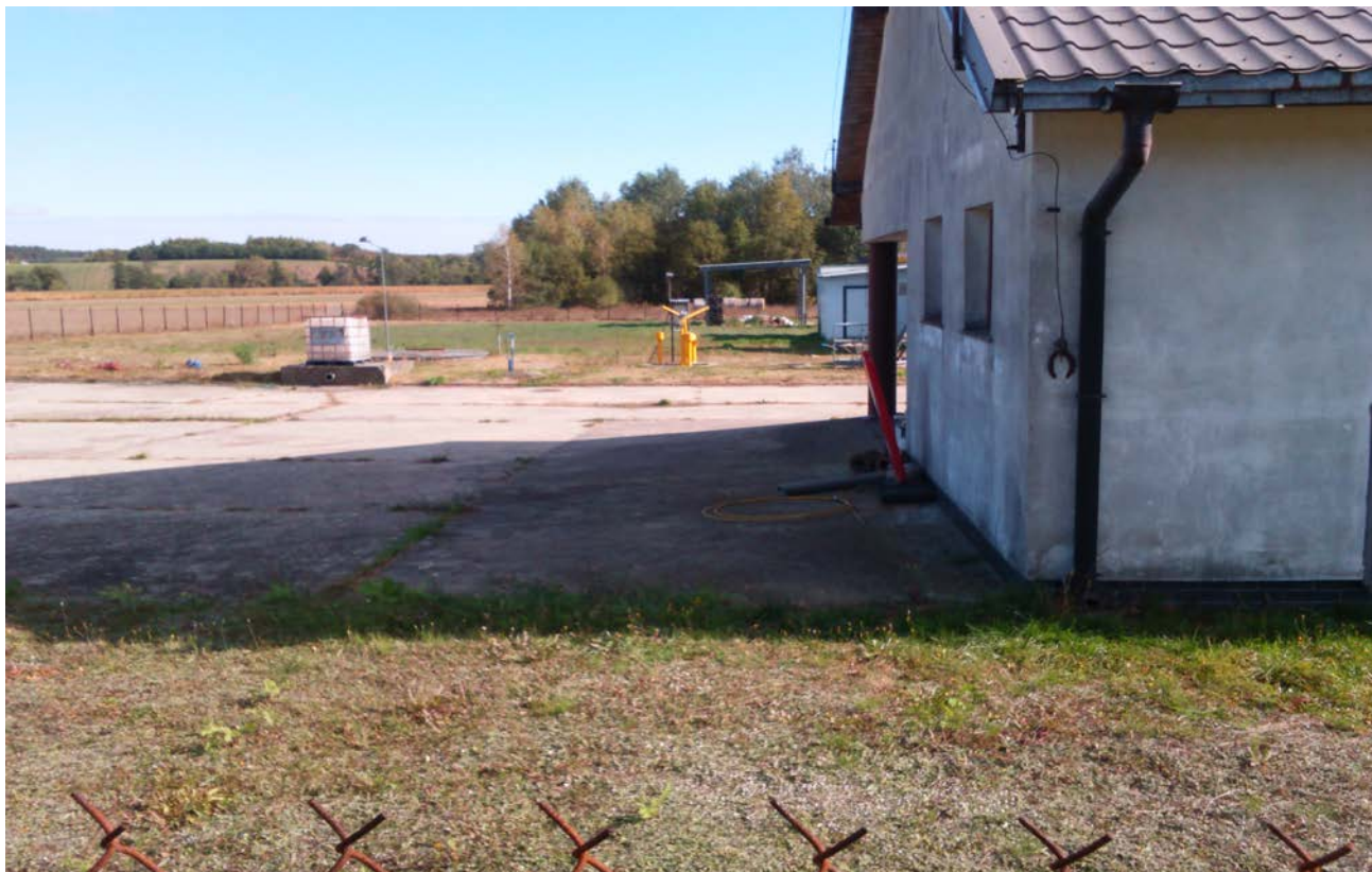
Fot. nr 10. Widok na teren oczyszczalni ścieków w Bądkowie Kościelnym
