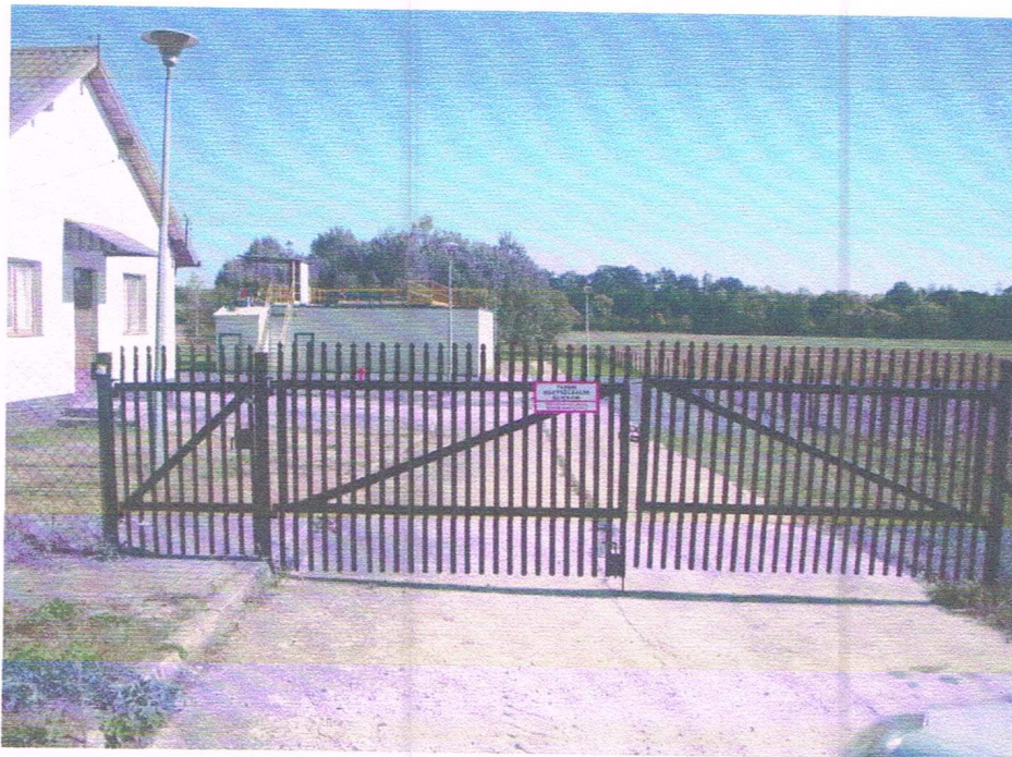
Fot. 9. Teren wokół oczyszczalni jest regularnie konserwowany ogrodzenie zostało poprawione i odmalowane.
