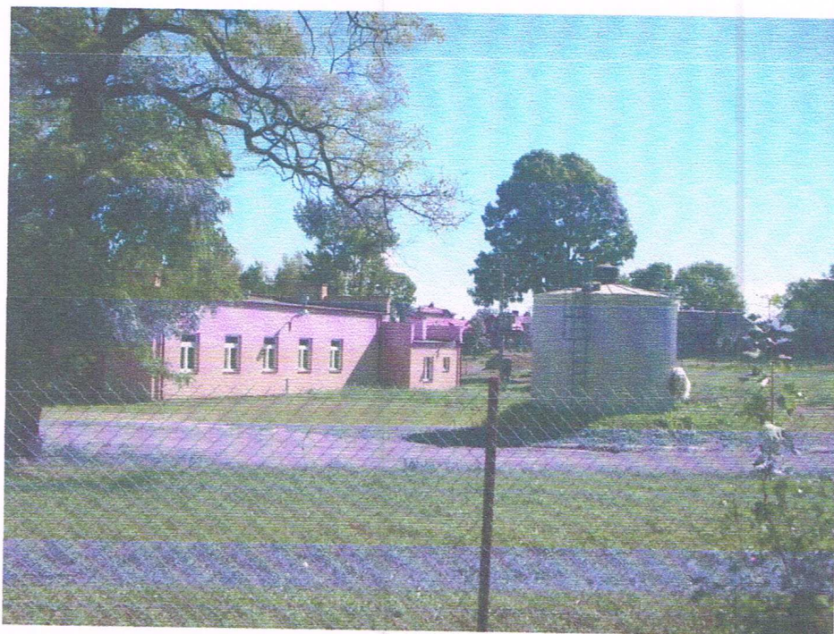
Fot. 7. Stacja w 2015 r była przygotowywana do modernizacji na rok 2016
