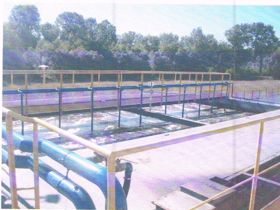
Fot. 11. Również i armatura została oczyszczona i odmalowana
