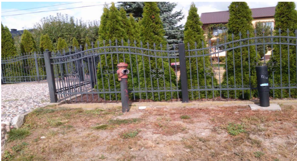
Fot. nr 18. Widok hydrantu w miejscowości Sikórz przy drodze do Bielska
