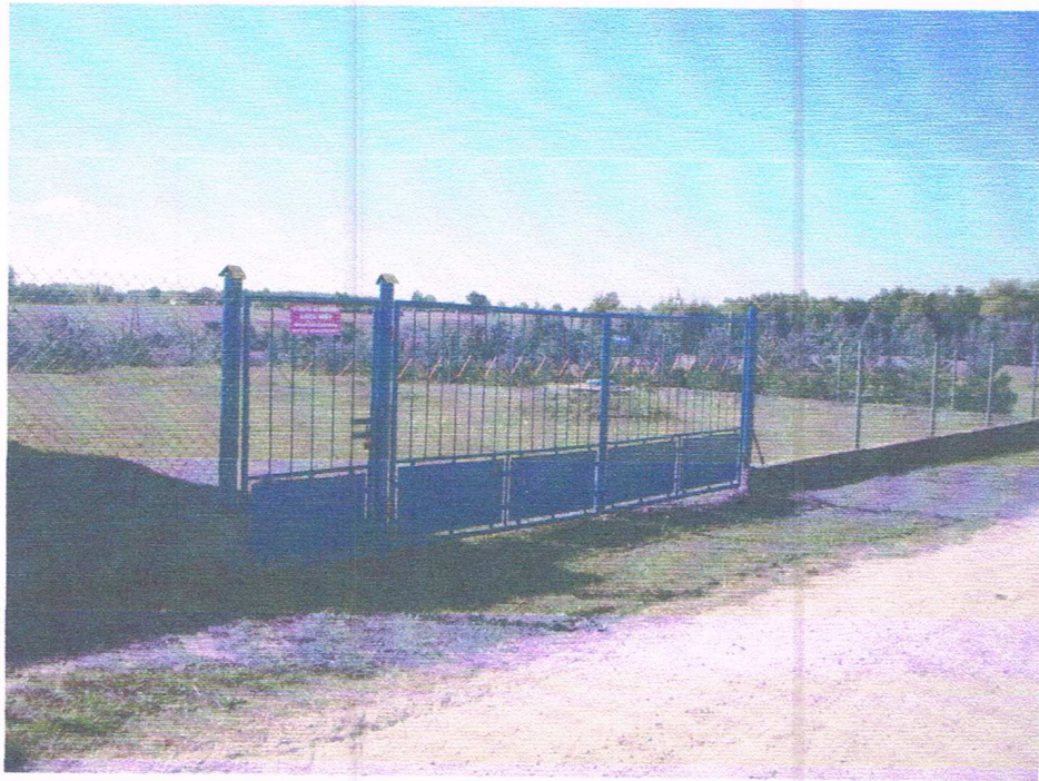
Fot. 5. Ogrodzenie Stacji jak i również przyległego terenu studni głębinowych zostało poprawione i odmalowane.
