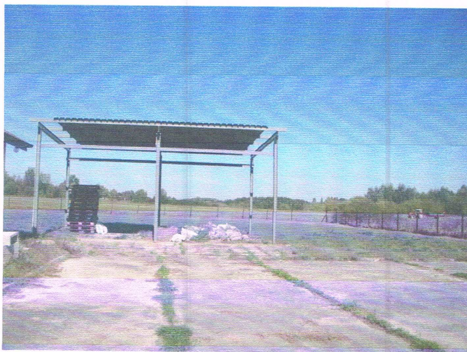
Fot. 10. Wiata na składowanie osadu została oczyszczona i odmalowana
