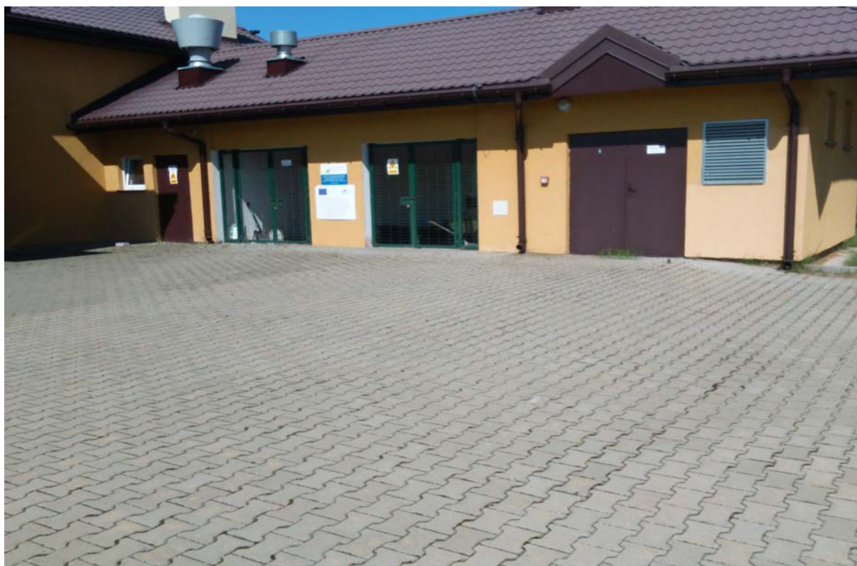
Fot. nr 3. Widok budynku oczyszczalni ścieków w Siecieniu
