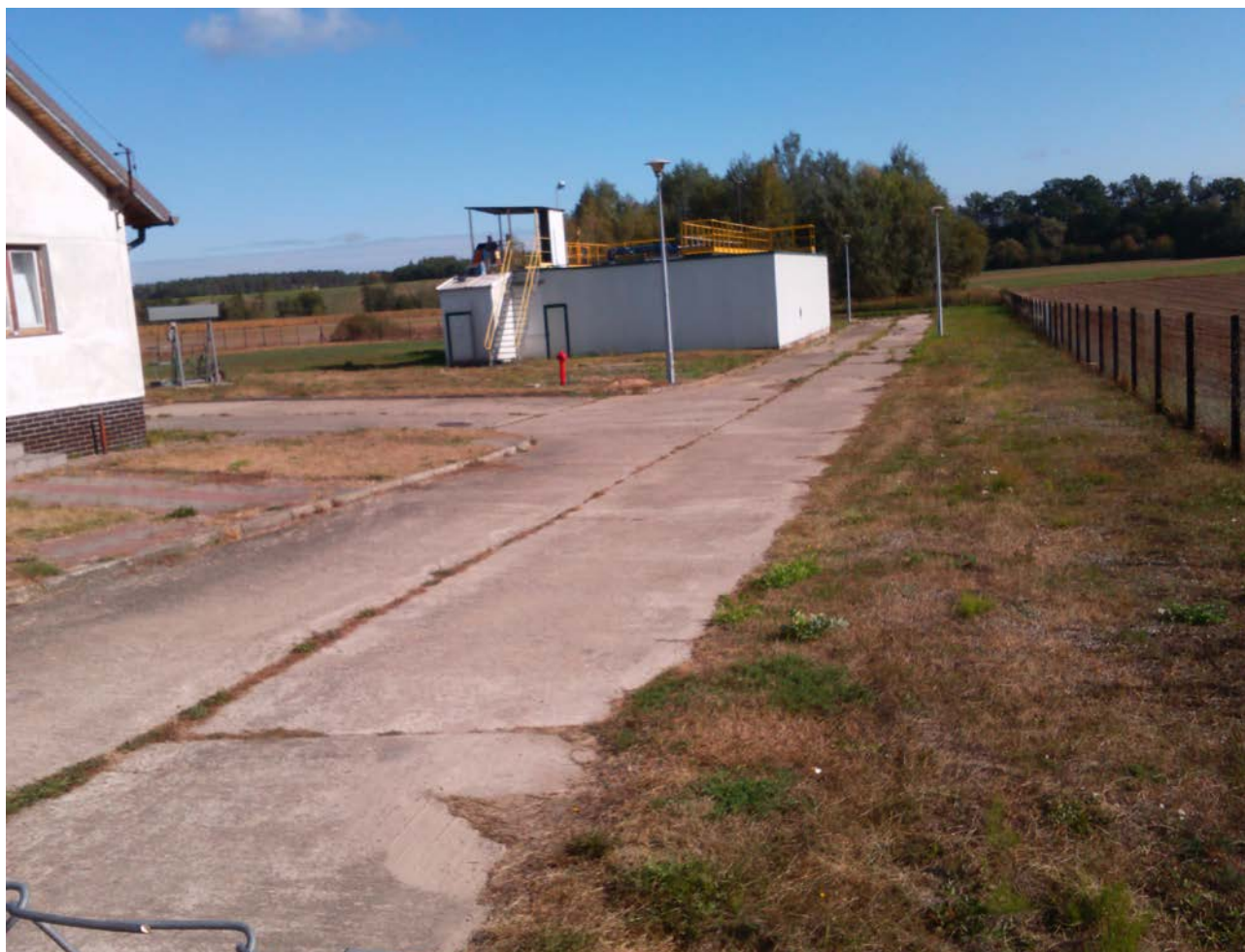
Fot. nr 9. Widok oczyszczalni ścieków w Bądkowie Kościelnym
