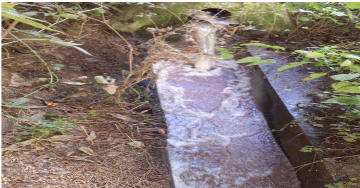
Fot. nr 11. Wylot z kanału odprowadzającego ścieki z oczyszczalni ścieków w Bądkowie Kościelnym
