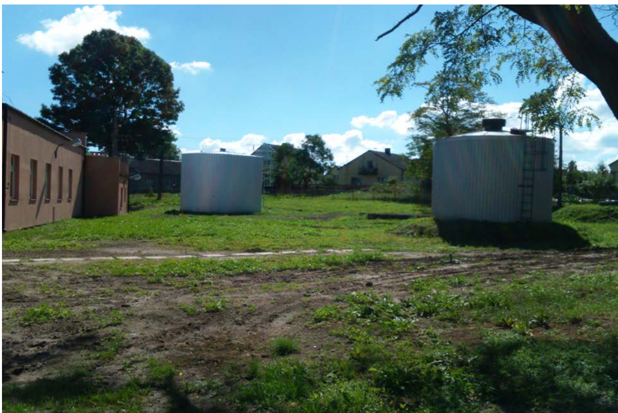
Fot. nr 1 Widok budynku stacji uzdatniania wody wraz ze zbiornikami zewnętrznymi w Siecieniu (w głębi nowy zbiornik)
